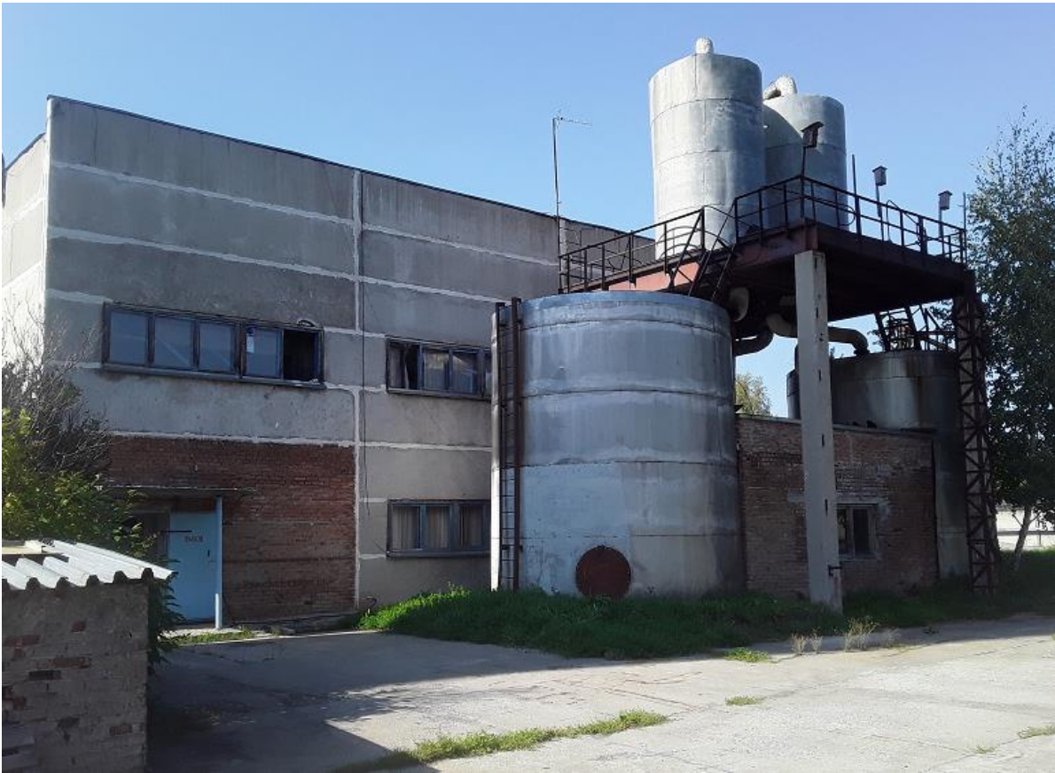
Рис.9 Баки умягченной воды
